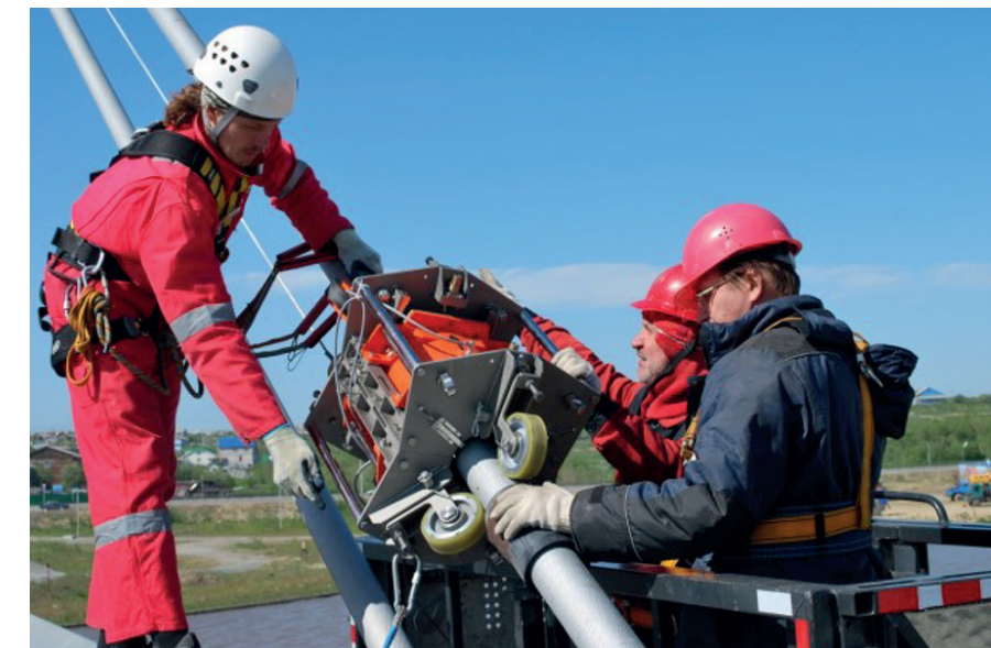
Фото 1. Дефектоскописты при помощи промышленного альпиниста устанавливают МГ 80-120 на ванту, изготовленную из каната закрытой конструкции (Салехард)
